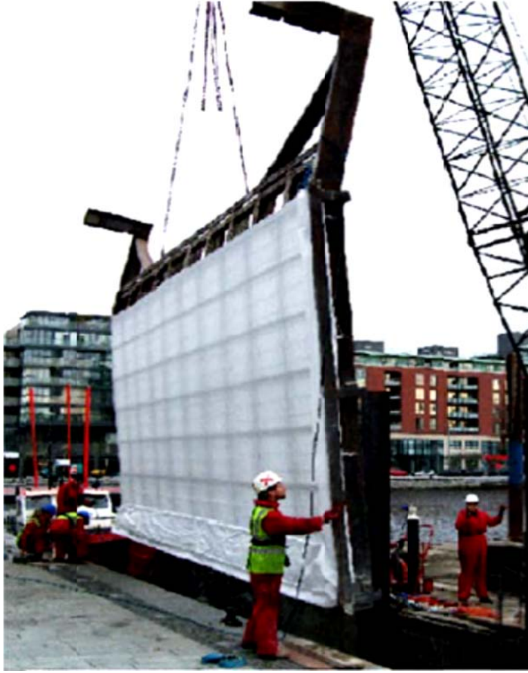
الشكل 15: استخدام قوالب النسيج لترميم جدران القناة الكبرى ( دبلن، أيرلندا 2007 ) [6]
