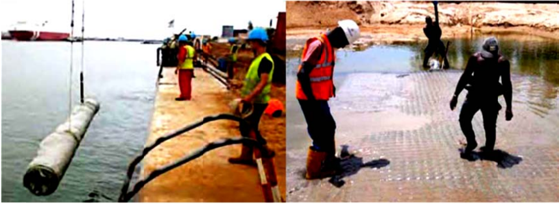
الشكل 10: استخدام المراتب النسيجية في ميناء كوتونو (بنين، أفريقيا 2011) [6]
