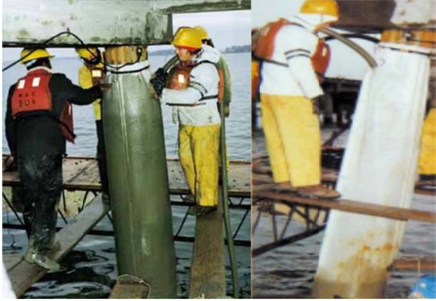
الشكل 13: استخدام نظام السترات النسيجية في ترميم الركائز البحرية [4]
