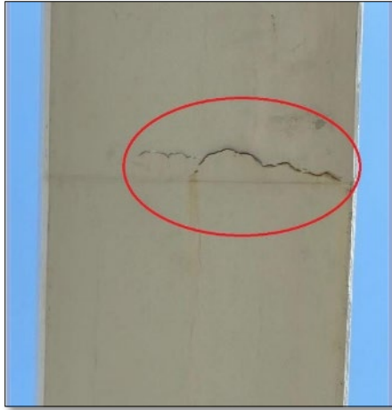
الشكل 4: التصدعات العرضية في الشدادات.
