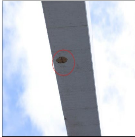
الشكل 5: التصدعات الطولية في الشدادات.
