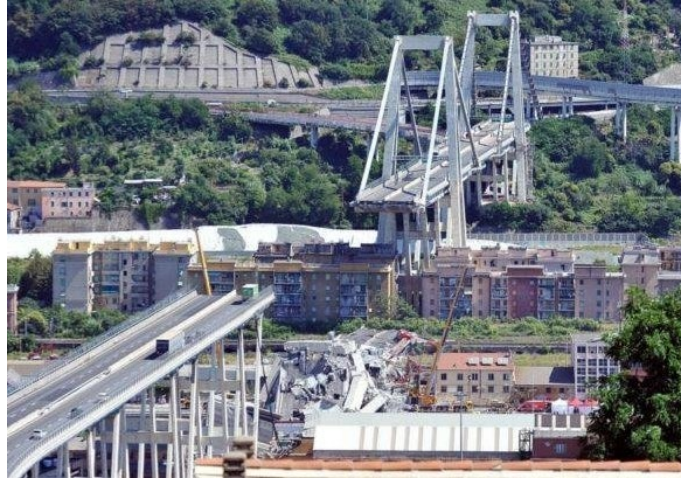
الشكل (7) جسر بولسيفيرا بعد الانهيار [5].
